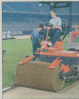
... und jetzt: In null Komma nichts wird der Rollrasen im Stadion aufgebracht.
